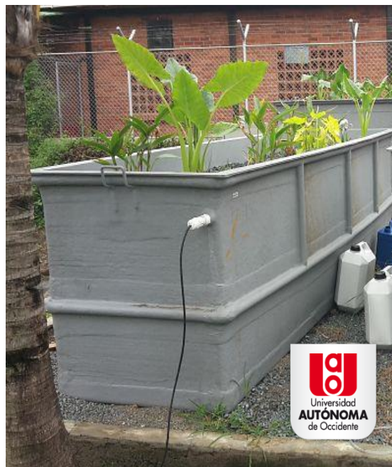
Figura 7. Humedad horizontal construido en la Universidad Autónoma de Occidente para realizar investigación en la tratabilidad de aguas residuales domésticas o industriales o efluentes de minería
