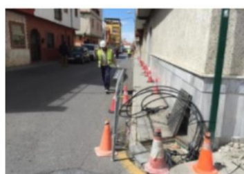
Figura 3. Tendido de FO terrestre [6]
