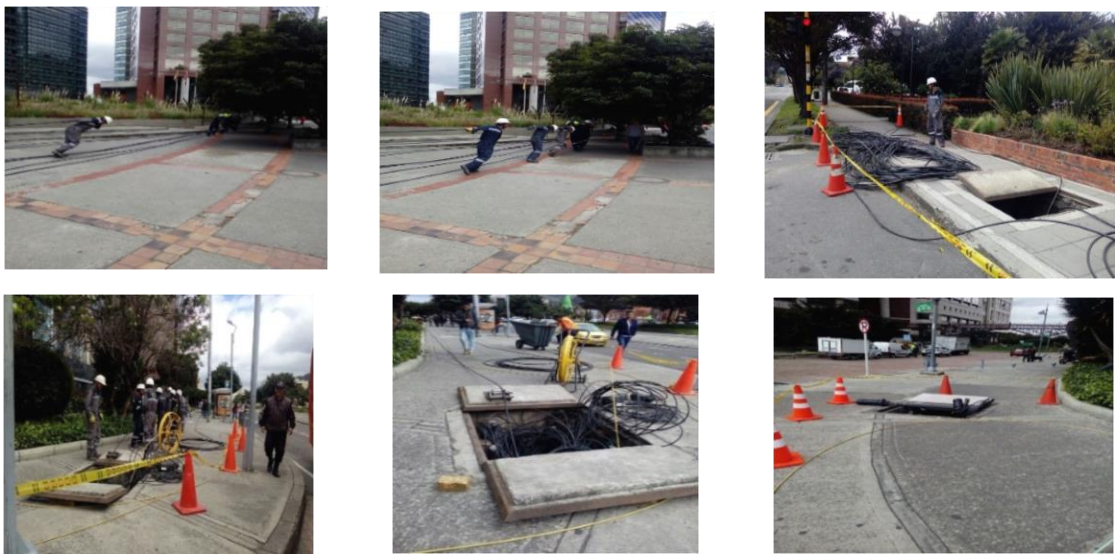
Figura 2. Tendido de FO terrestre [4]
